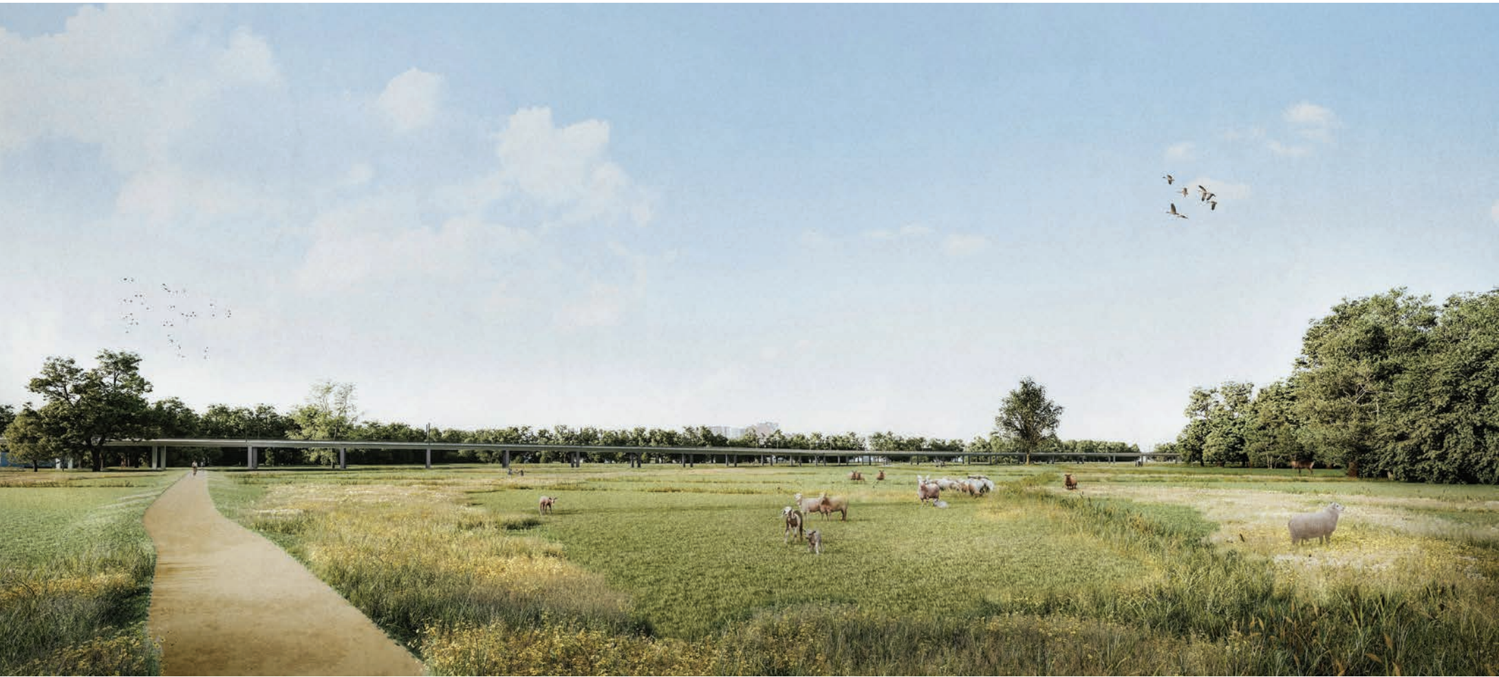
Die neue Brücke über den Regnitzgrund in Erlangen
